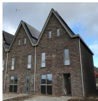
Goedkeuring verkregen voor aankoop van 13 eengezinswoningen van project Reitdiep in Groningen.
