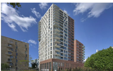
Oplevering 218 appartementen in Lammenschans (Blok F) in Leiden.
